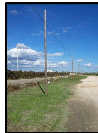
Foto 5: vista palificata con muro diruto da rimuovere
